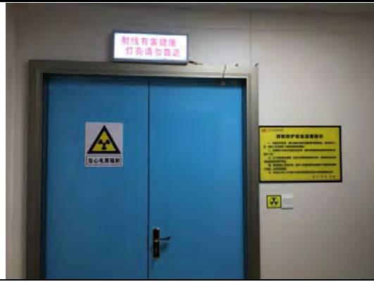
病人防护门警示灯及电离辐射警示标示
