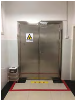
控制区入口防护门门禁及警示标识
